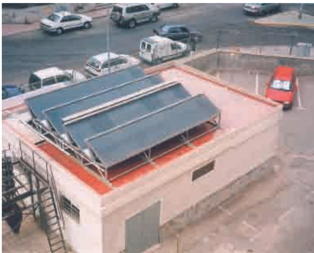
Cubierta solar instalada en la Escuela de Ingenieros Industriales de la Universidad Politécnica de Cartagena (Murcia)
