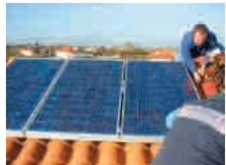
En la foto superior se puede observar la instalación una vez concluida. Sobre estas líneas, una de las etapas del montaje de los paneles solares.
