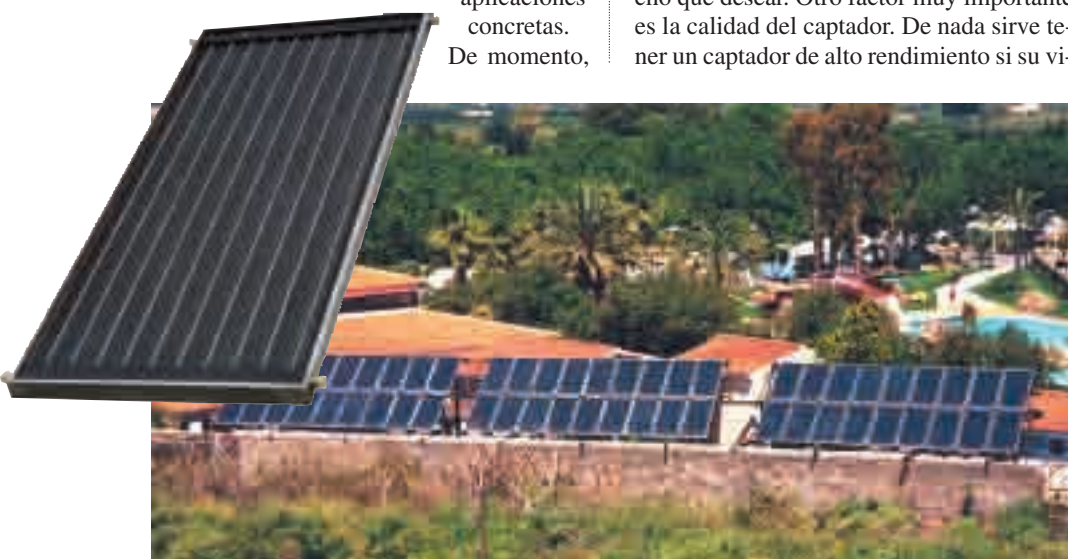
Instalación realizada por Atesa en un camping de Salou (Tarragona). El colector solar es el modelo Atesa Export Tridimensional, llamado así por que la superficie absorbente está salpicada de pequeñas esferas que, según el fabricante, aumentan un 37% la superficie útil de captación.
