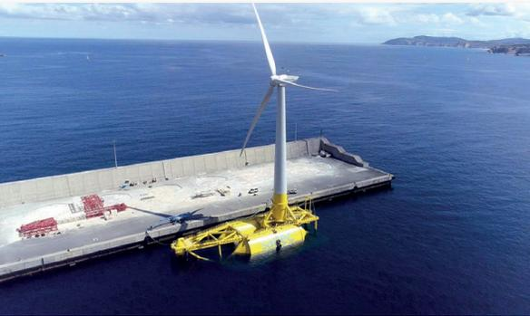
**D**emoSATH, el prototipo de plataforma flotante desarrollado por la ingeniería vasca Saitec Offshore Technologies, ha sido instalado a mediados de este mes de agosto en alta mar, en aguas del área marina de ensayos BiMEP, a dos millas de distancia de la costa vizcaína. La plataforma, sobre la que se encuentra un aerogenerador de dos megavatios de potencia, ha sido trasladada desde el Puerto de Bilbao por Alianza Windstaller.
