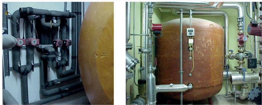
Ejemplo de accesorios de instalaciones aislados (izq.) y sin aislamiento térmico (der.)
