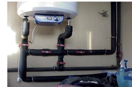
*Ejemplos de sistemas de manipulación compleja y antiestética que se deberían evitar, según la guía de ASIT*
