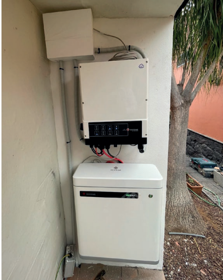
Instalación de autoconsumo con el inversor híbrido de GoodWe EM y la batería modelo Lynx Home U.
