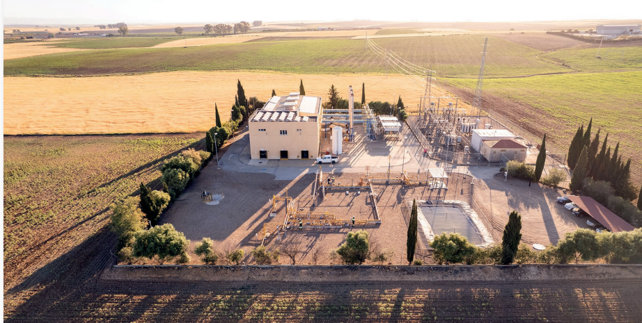
Instalación de hibridación gas natural-fotovoltaica de Tarba Energía, en la localidad sevillana de Carmona
