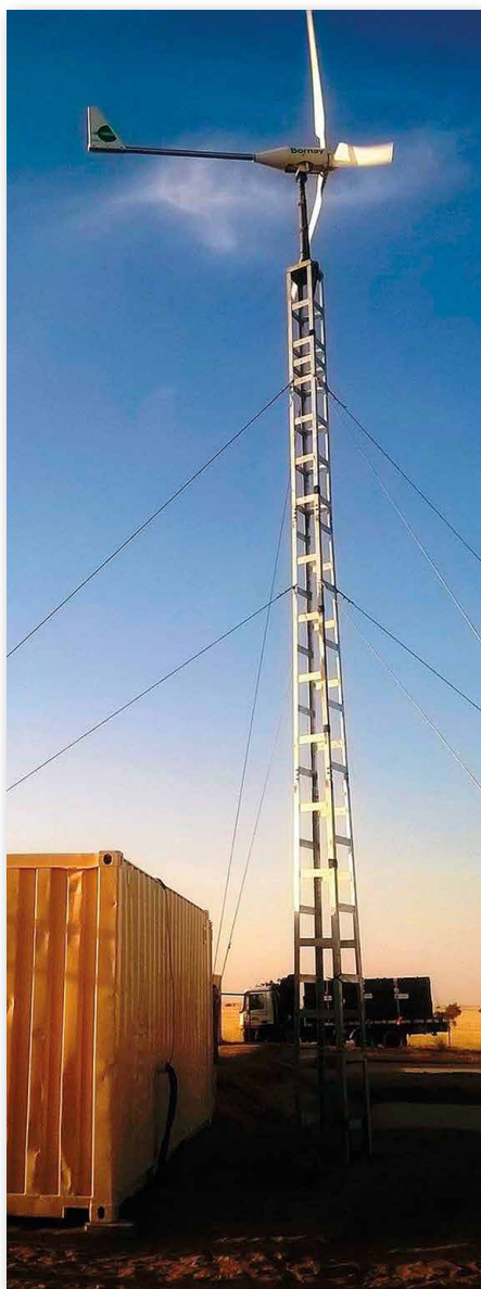
Instalación en el Chad, con un aerogenerador Bornay 6000, paneles solares y baterías estacionarias. La realizó Sahara Conservation Fund en 2016
