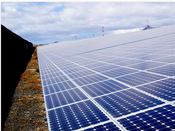
Imagen de la presentación y paneles fotovoltaicos del proyecto FOTOBAT 5 + 5, una planta fotovoltaica de 5 MW de potencia y 5 MWh de acumulación, en Arico, Tenerife, un modelo piloto en el que se comprobará la viabilidad técnica y económica de acometer instalaciones solares de media-gran potencia conectadas a red sin retribución específica bonificada, según el marco legislativo actual.
