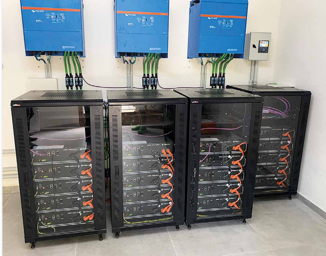
Baterías de litio Pylontech con inversores/cargadores de Victron para una instalación fotovoltaica en una vivienda en Benissa (Alicante). Realizada por Lucafar
