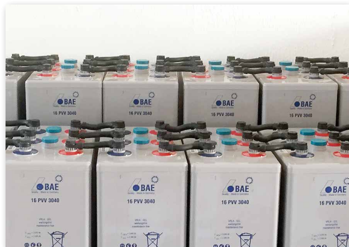
Banco de baterías estacionarias BAE para un proyecto fotovoltaico de Energía sin Fronteras en Benin, que ofrece electricidad a un poblado de enfermos de lepra. La empresa instaladora es Gamo Energías
