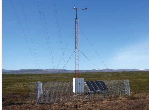
Instalación en Islandia. Consta de un aerogenerador Bornay 13+, un panel fotovoltaico, un regulador Schneider y baterías estacionarias. La empresa instaladora es Measwind Renewable Services
