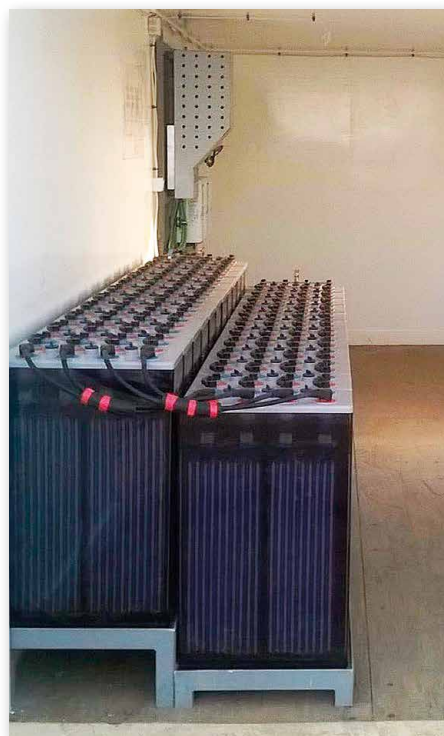
Instalación en el Chad, con un aerogenerador Bornay 6000, paneles solares y baterías estacionarias. La realizó Sahara Conservation Fund en 2016
