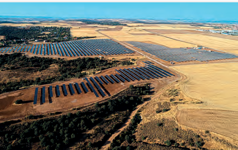
Planta solar fotovoltaica de 13MWp en El Casar (Guadalajara), desarrollada por Alten Energías Renovables y construida por Grupo Ortiz con financiación de Triodos Bank.
