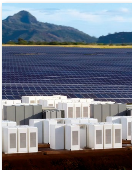
Sobre estas líneas, instalación en la isla de Kauai (Hawai), integrada por una planta FV de 13 MW y más de 270 baterías de Tesla.
