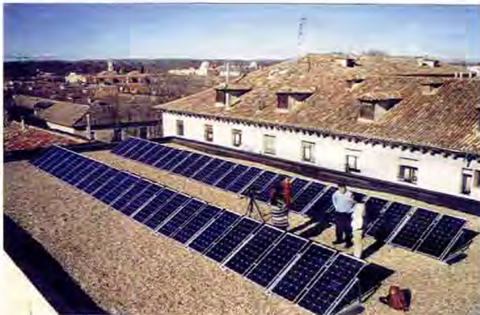
Tejado de la sede del sindicato UGT en la localidad madrileña de Aranjuez. La instalación fotovoltaica tiene una potencia nominal de 5 kW.
