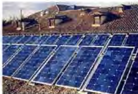
Tejado de la sede del sindicato UGT en la localidad madrileña de Aranjuez. La instalación fotovoltaica tiene una potencia nominal de 5 kW.
