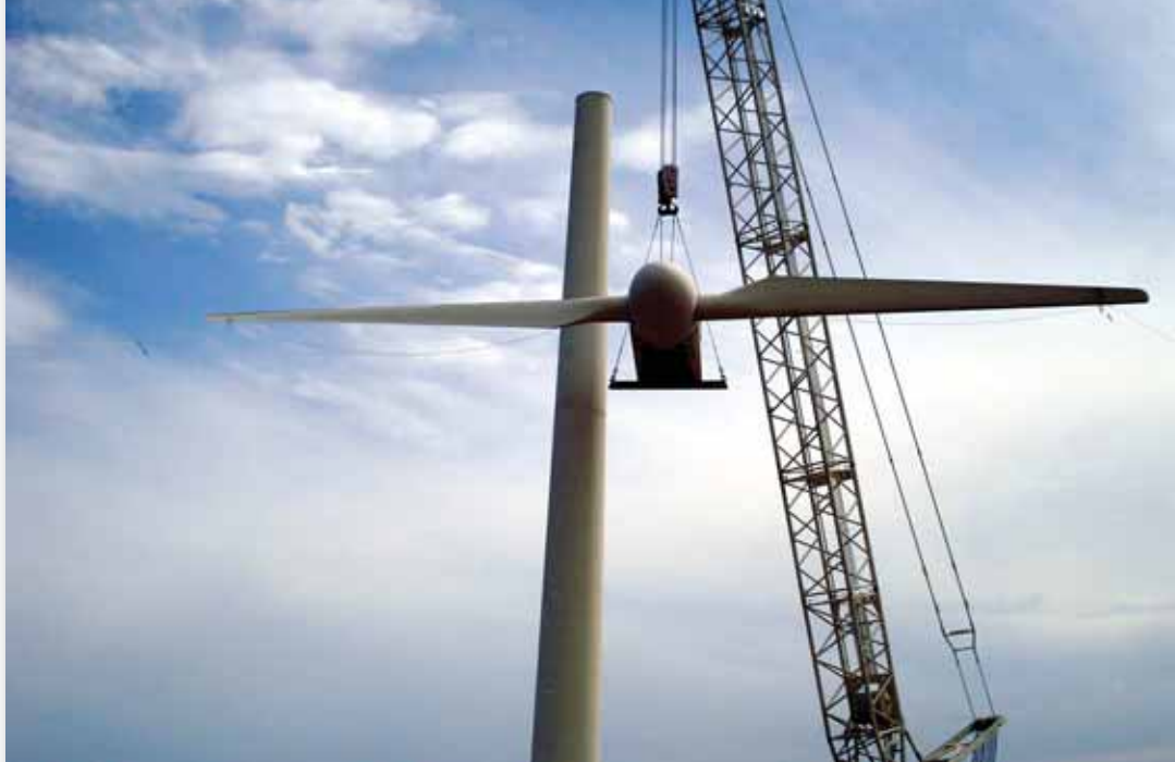
Instalación de un aerogenerador en el parque eólico Nuevo Manantial (10 MW), Rocha, Uruguay.
