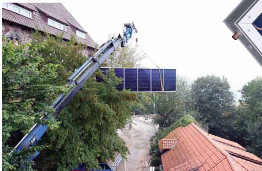
Arriba, instalación solar térmica del parque acuático de Cerceda, en A Coruña. Abajo, imagen de una fase del proceso de instalación de una batería de captadores LBM.
