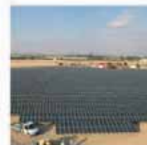
Planta Fotovoltaica en Murcia
