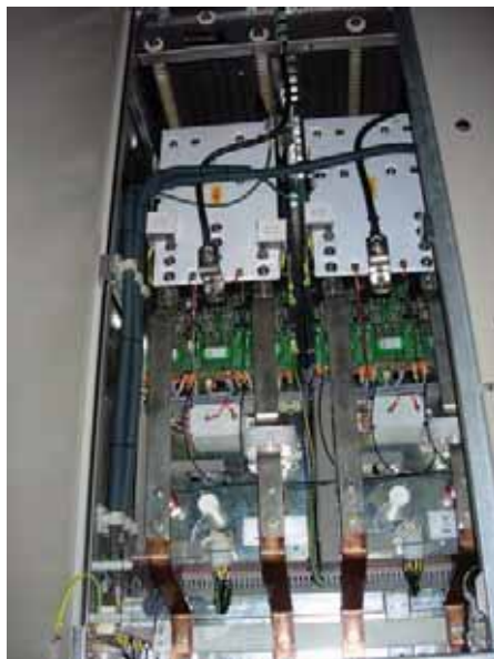
A la izquierda, equipo de compensación instalado en el aerogenerador NEG Micon 900/52 de 900 kW. Arriba, instalación del equipo en el interior del aerogenerador.
