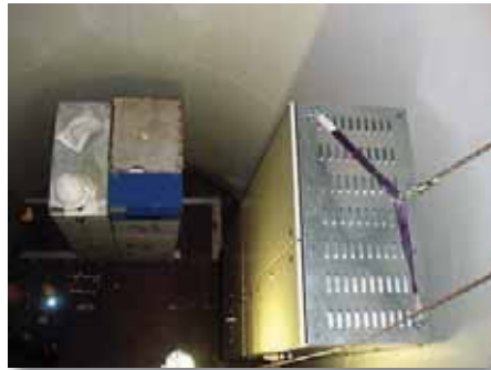
A la izquierda, equipo de compensación instalado en el aerogenerador NEG Micon 900/52 de 900 kW. Arriba, instalación del equipo en el interior del aerogenerador.
