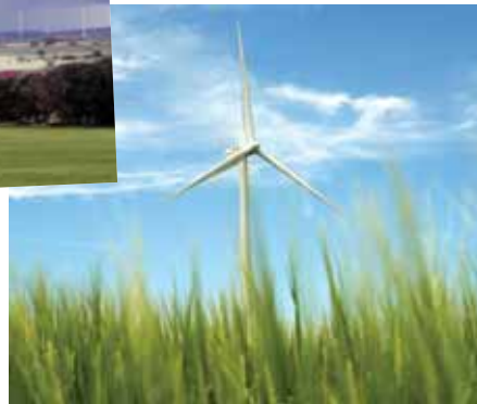
Iberdrola ha escogido el G-87 de Gamesa, un aerogenerador de 78 metros de altura con una longitud de pala de 42,5 metros que actúa en un área de barrido de 5.945 m 2 . Con estos molinos, Iberdrola montó el parque eólico de Maranchón, en Guadalajara.
