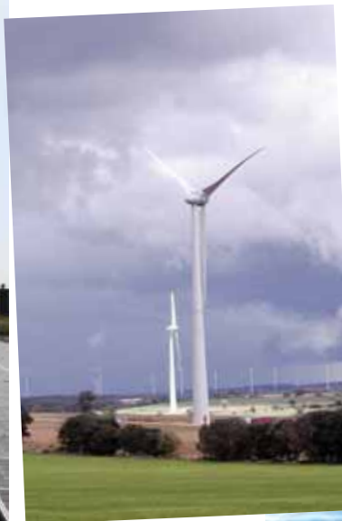
Iberdrola ha escogido el G-87 de Gamesa, un aerogenerador de 78 metros de altura con una longitud de pala de 42,5 metros que actúa en un área de barrido de 5.945 m 2 . Con estos molinos, Iberdrola montó el parque eólico de Maranchón, en Guadalajara.
