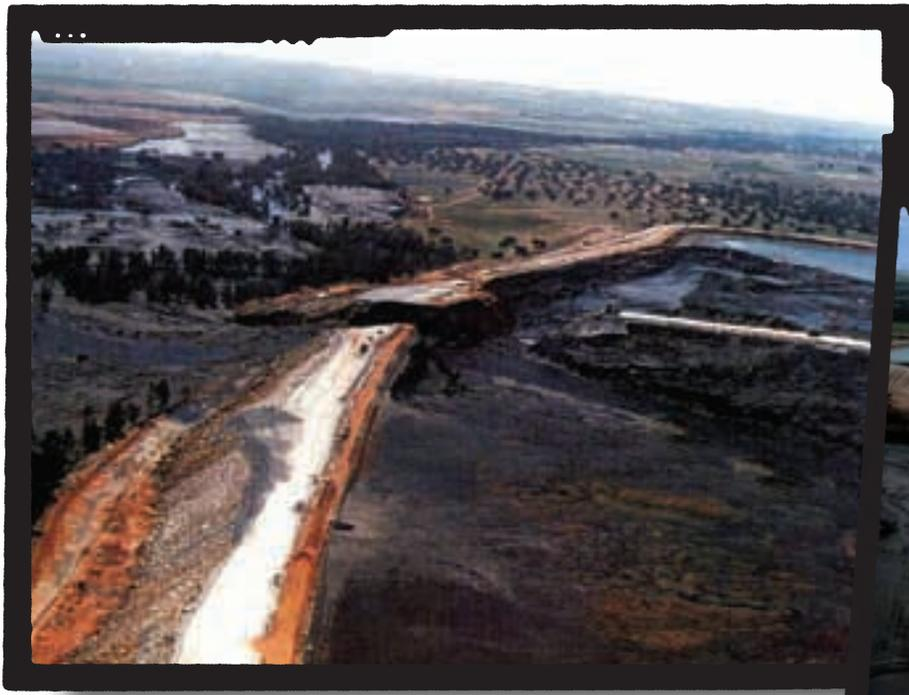
Dos imágenes de la rotura de la presa de contención de la balsa de residuos de de las minas de Boliden-Apirsa en Aznalcóllar que originó el vertido en el entrono de Doñana.
