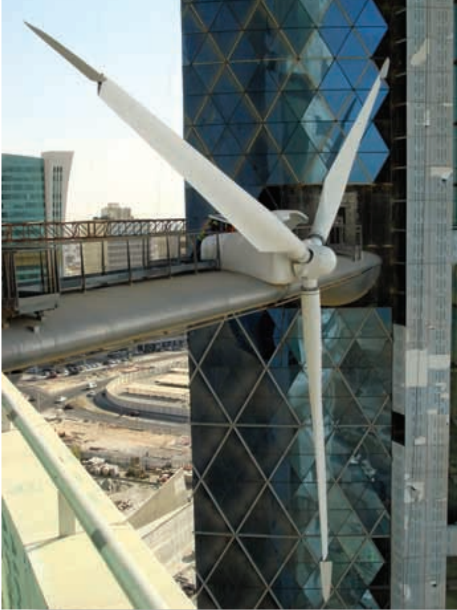
El Bahrain World Trade Center (BWTC) es el primer edificio del mundo que integra aerogeneradores de un tamaño considerable. Aunque existen infinidad de proyectos arquitectónicos en este sentido, ninguno se había hecho realidad hasta ahora.
