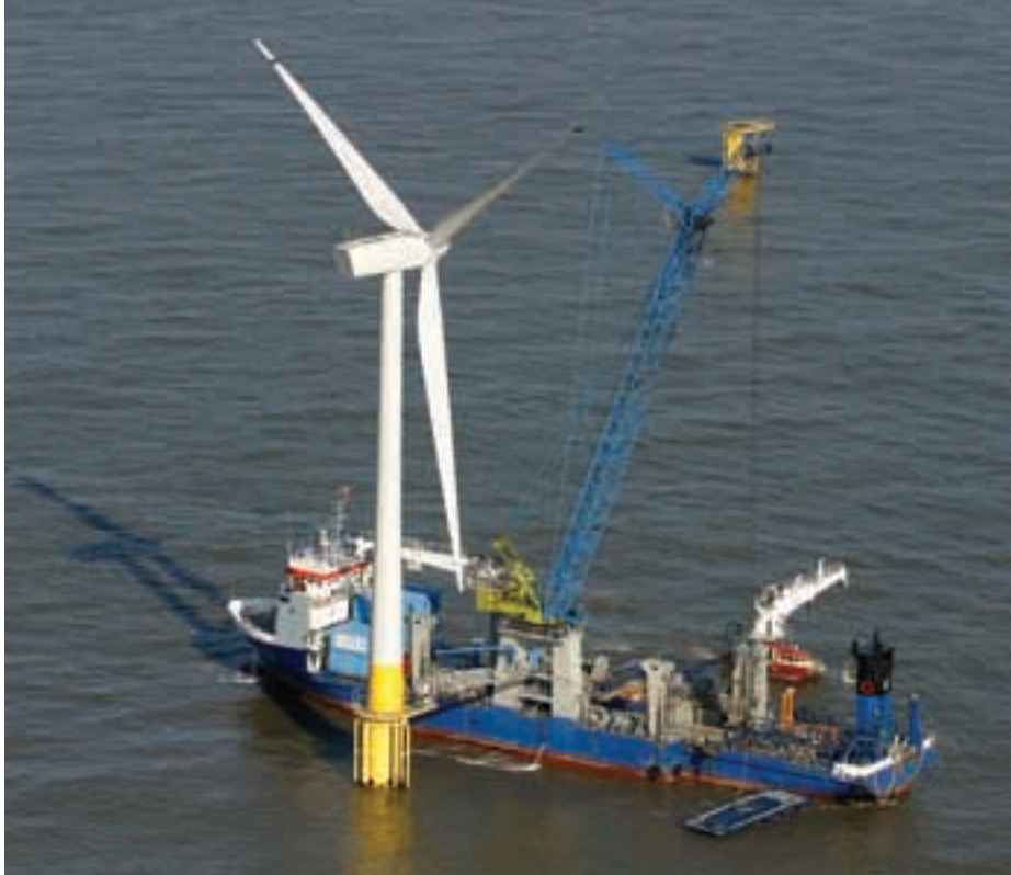
Instalación de un aerogenerador en el parque eólico de Scroby Sands, Reino Unido.
