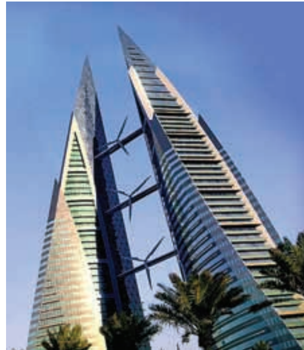
El Bahrain World Trade Center (BWTC) es el primer edificio del mundo que integra aerogeneradores de un tamaño considerable. Aunque existen infinidad de proyectos arquitectónicos en este sentido, ninguno se había hecho realidad hasta ahora.
