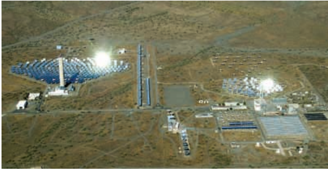
Espectacular imagen aérea de la Plataforma Solar de Almería, establecimiento dependiente del Centro de Investigaciones Energéticas, Medioambientales y Tecnológicas de España (CIEMAT) que se ha convertido en uno de los referentes mundiales en la I+D+i solar
