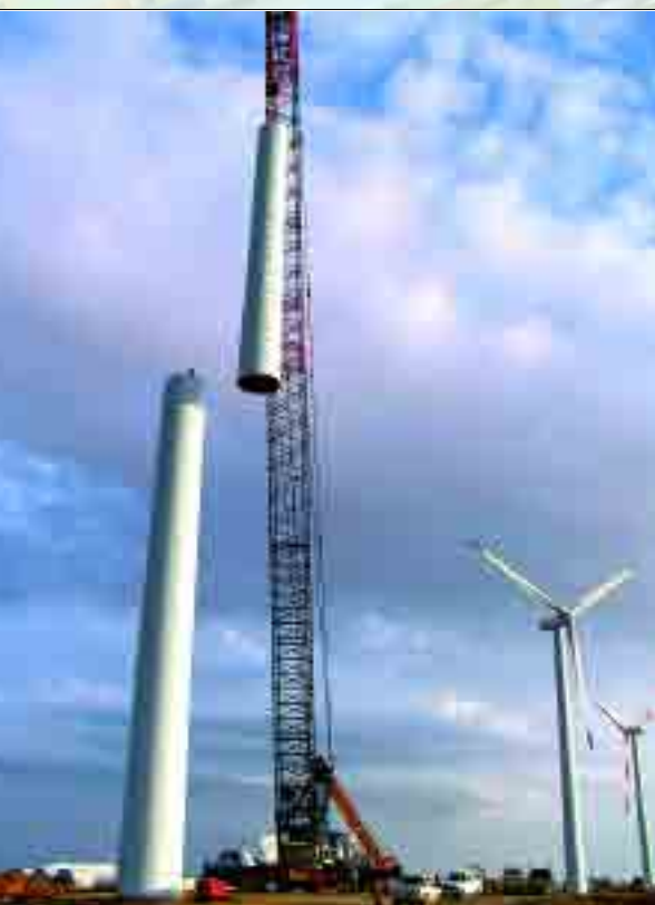
Montaje de aerogeneradores en Guajira, Colombia.
