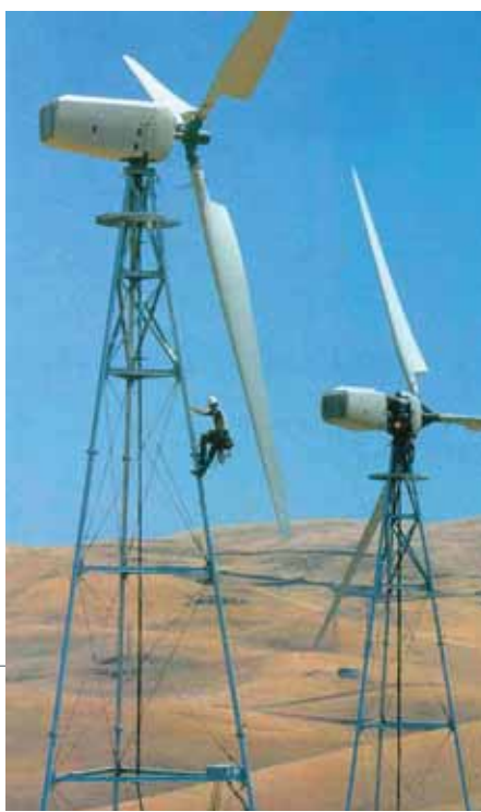
Aerogenerador PESUR AWP 56-100 (1992) en Tarifa.
