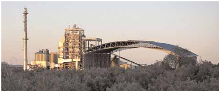
Andalucía es la primera región española en cuanto al aprovechamiento de los recursos agrícolas, forestales e industriales con fines energéticos, y el olivar, una de las fuentes fundamentales de biomasa para sus centrales de producción de energía renovable.
