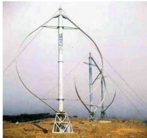
Aerogeneradores CENEMESA 300 kW en Tarifa (Cádiz), 1985.
