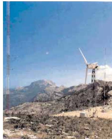
Planta de ensayos en Alfabiá (Mallorca).
