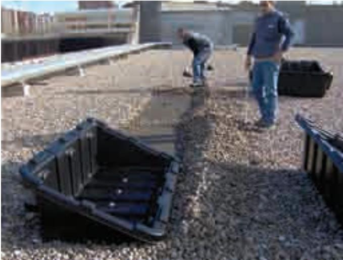
La instalación fotovoltaica se completa con un tercer campo de captación situado en la cubierta del edificio. Son 384 módulos monocristalinos que también aportan novedades en su montaje.
