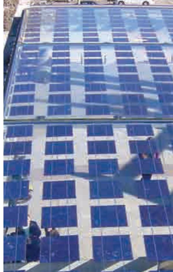
La Vaguada está coronada por 24 módulos de vidrio fotovoltaico. Son tres filas con ocho módulos cada fila que se construyeron prácticamente a medida.
