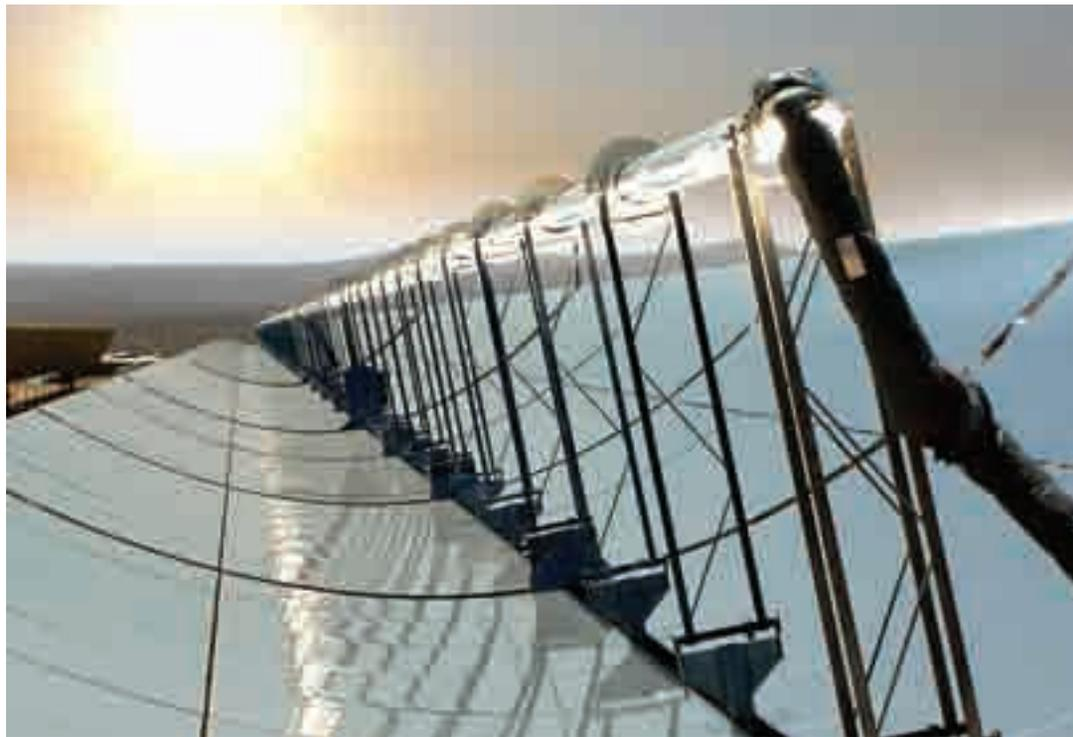
El centro neurálgico del tubo receptor es la unión entre el tubo absorbedor y el tubo envolvente de vidrio, sellada mediante vacío. Para la unión entre el vidrio y el metal Schott ha desarrollado un nuevo vidrio borosilicato, que presenta el mismo coeficiente de dilatación térmica que el metal utilizado. Gracias a ello, la unión soporta de forma fiable los cambios de temperatura extremos que se dan entre las noches frías y el calentamiento que
