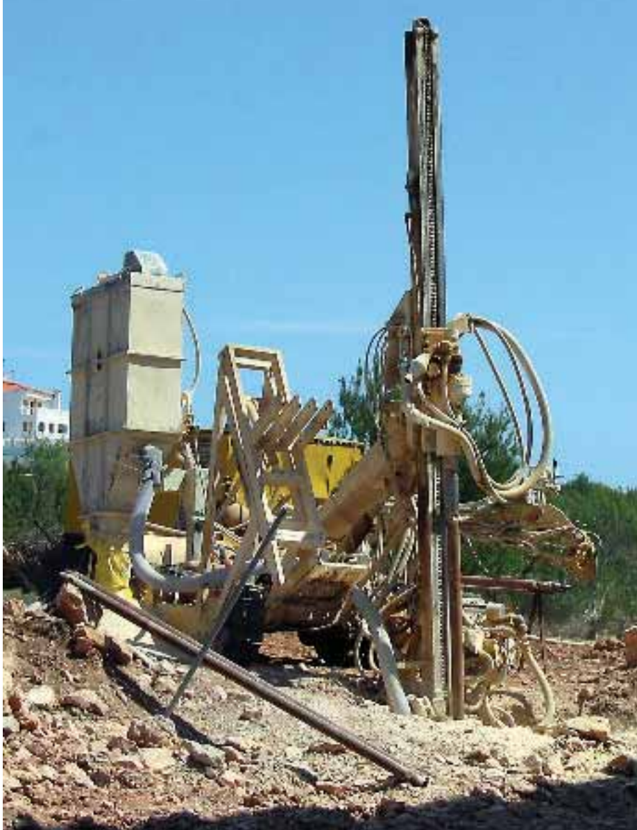
La parte más delicada y cara del proceso es la perforación. Energesis está trabajando en la especialización de sus ingenieros, y en la mejora y perfeccionamiento de las máquinas de perforación, que cada vez son más robustas.
