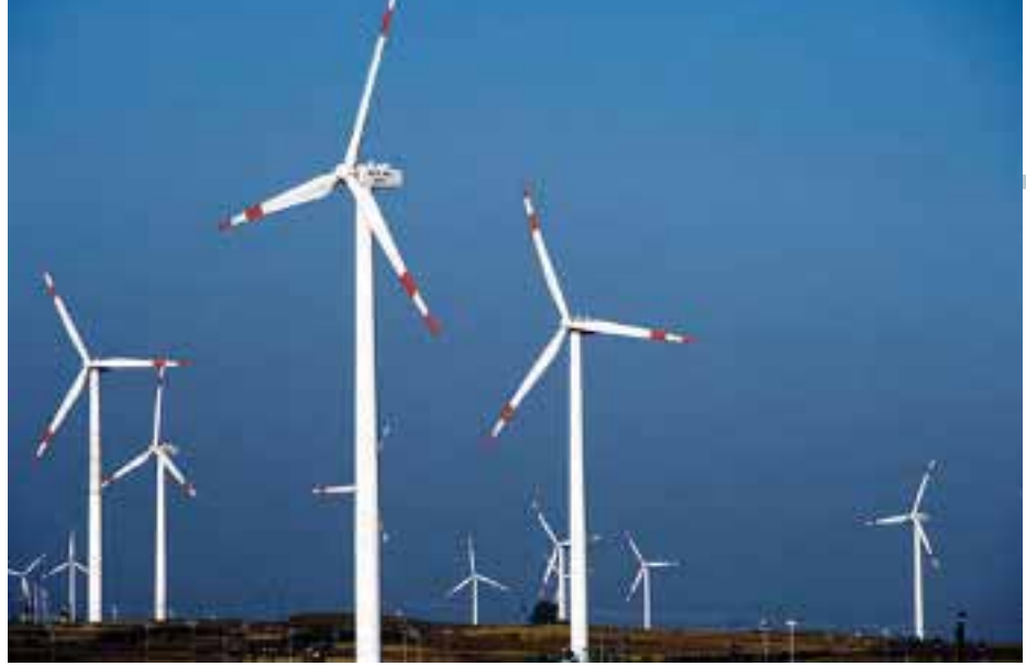
Aerogeneradores Suzlon S64 de 1.25 MW en el parque eólico de Dhule cerca de Nandurbar en Maharashtra, India.
