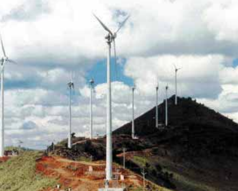
Parque eólico de 8.4 MW en Karnataka.
