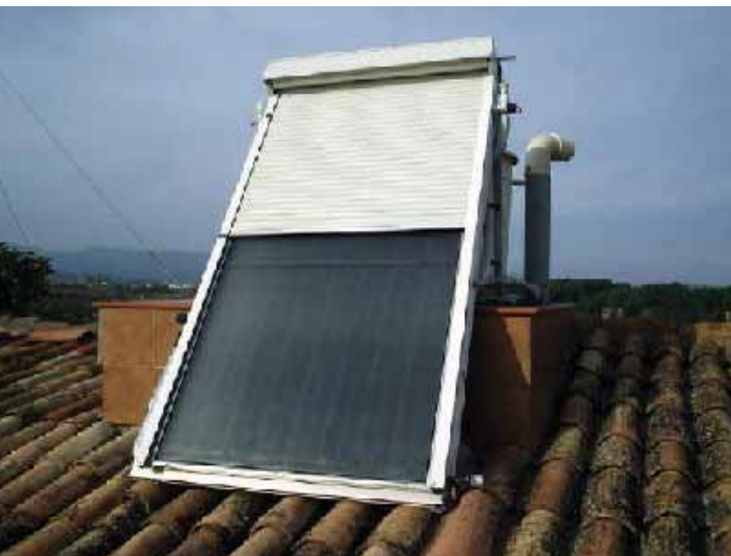
Arriba, el colector solar a primera hora de la mañana. Abajo, la temperatura del agua caliente ha llegado a 60°C y el control actúa.
