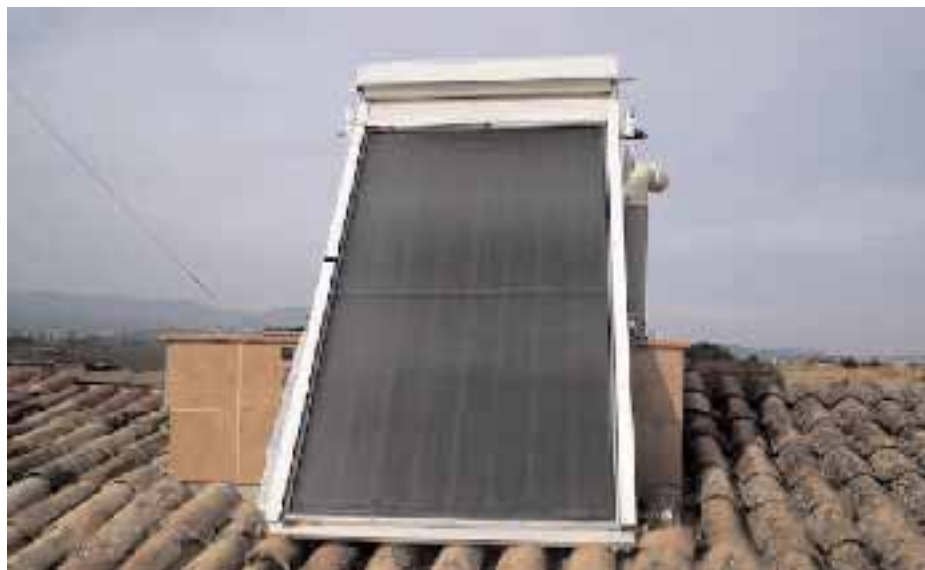
Arriba, el colector solar a primera hora de la mañana. Abajo, la temperatura del agua caliente ha llegado a 60°C y el control actúa.
