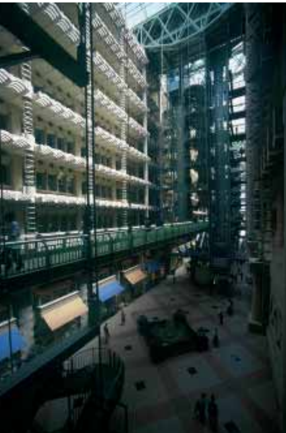
Edificio Eastgate en Harare, Zimbabue. Una imagen de su vestíbulo central y un esquema de su funcionamiento térmico. Mick Pearce, su arquitecto aplicó un diseño basado en el sistema de corrientes de ventilación que utilizan las termitas en los enormes termiteros de su país, construyendo un edificio que no necesita aparatos de aire acondicionado ni apenas calefacción. Los resultados de esta estrategia han supuesto un ahorro de 3,5 millones de dólares al propietario y un abaratamiento del 20% en los alquileres para los inquilinos.
