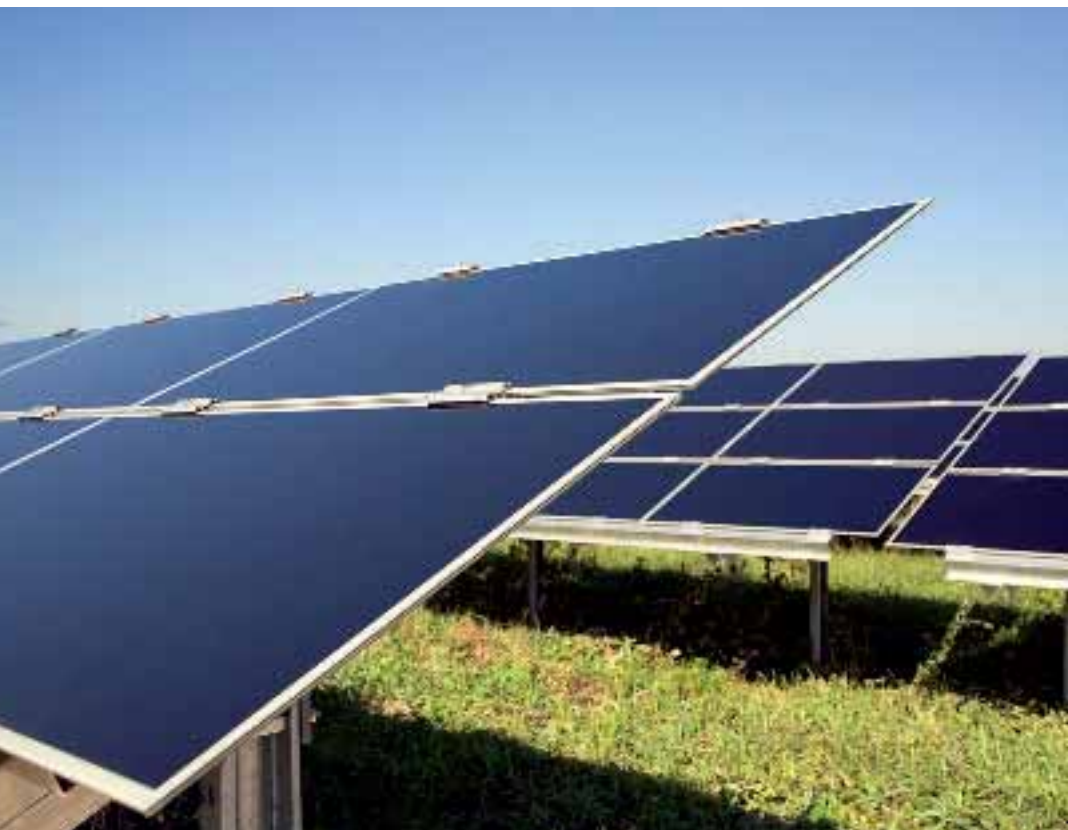
Planta de 1,7 MW en Merin (Alemania). Es una de las mayores instalaciones del mundo con tecnología de capa fina.
