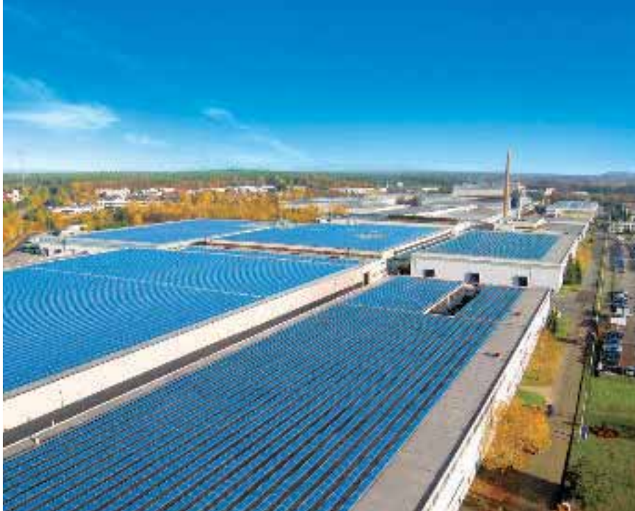
Las dos fotos grandes de estas páginas son tejados de naves de Michelin en Alemania. Hay 9 MW instalados en las provincias de Landau, Homburg, Bad Kreuznach y Bamberg. En total, una superficie de 200.000 m 2 . La foto pequeña es de la Misión Permanente de los Estados Unidos en Ginebra, Suiza.
