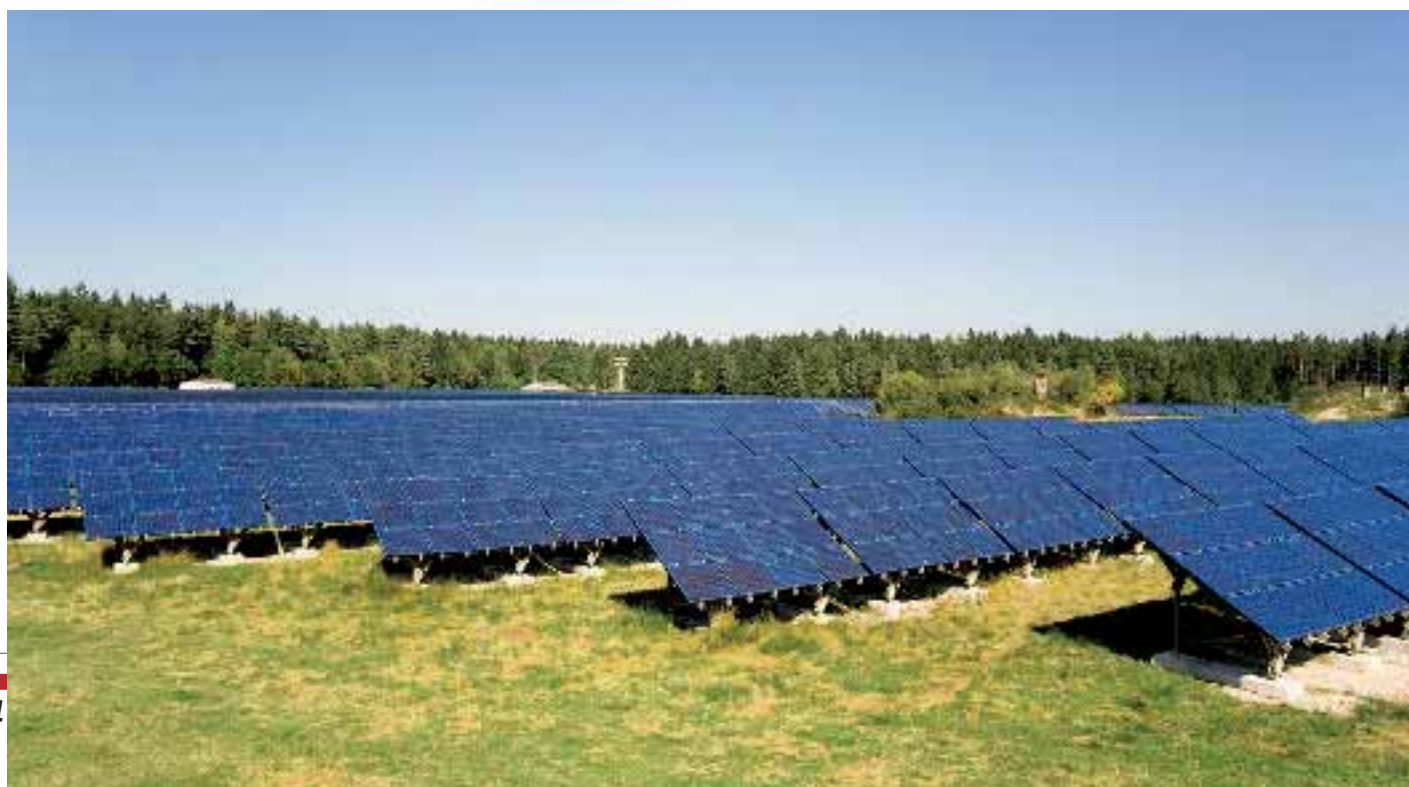
Arriba, oficinas de SunTechnics en Madrid. Abajo, parque de Hemau (Alemania) que con una potencia instalada de 4MWp fue durante años el mayor del mundo.
