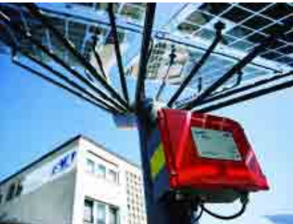
El inversor Sunny Boy de SMA es el producto más conocido de esta empresa alemana y cuenta con distintas versiones, según las necesidades de la instalación. Las fotos son de la sede central de SMA en Niestetal (Alemania).
