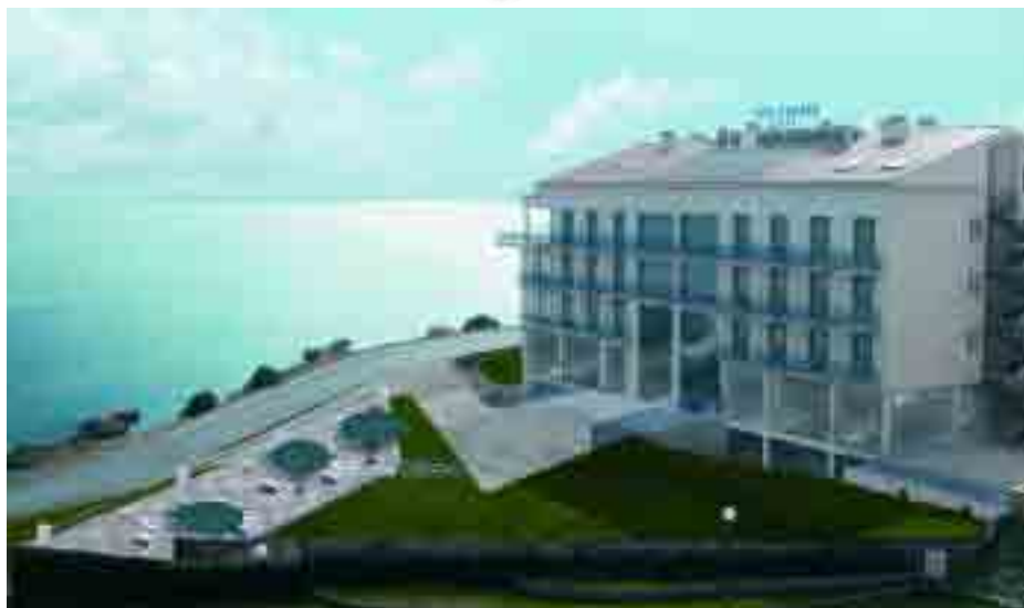
El hotel Flamingo, de 4 estrellas, cuenta con una instalación mixta que combina la biomasa con la energía solar. Consigue cada año un ahorro energético de 78.200 kWh.
