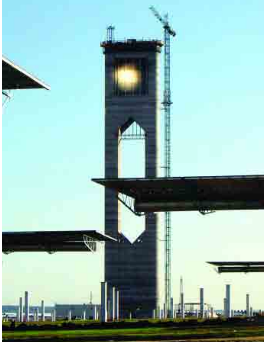
En la torre, a 100 m de altura, se ubica el receptor térmico volumétrico formado por una matriz de varias capas de mallas metálicas que luego calentarán el circuito de agua a una temperatura máxima de 255° C.
