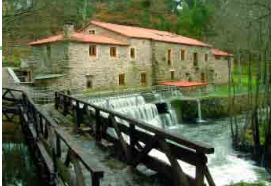
Casa rural en la localidad de O Pino, en A Coruña, dotada con una instalación minihidráulica. Se trata de un modelo Power Pal que aprovecha un salto de tres metros y un caudal de 600 litros por segundo para producir 9 kilovatios y abastecer de calefacción a la casa.
