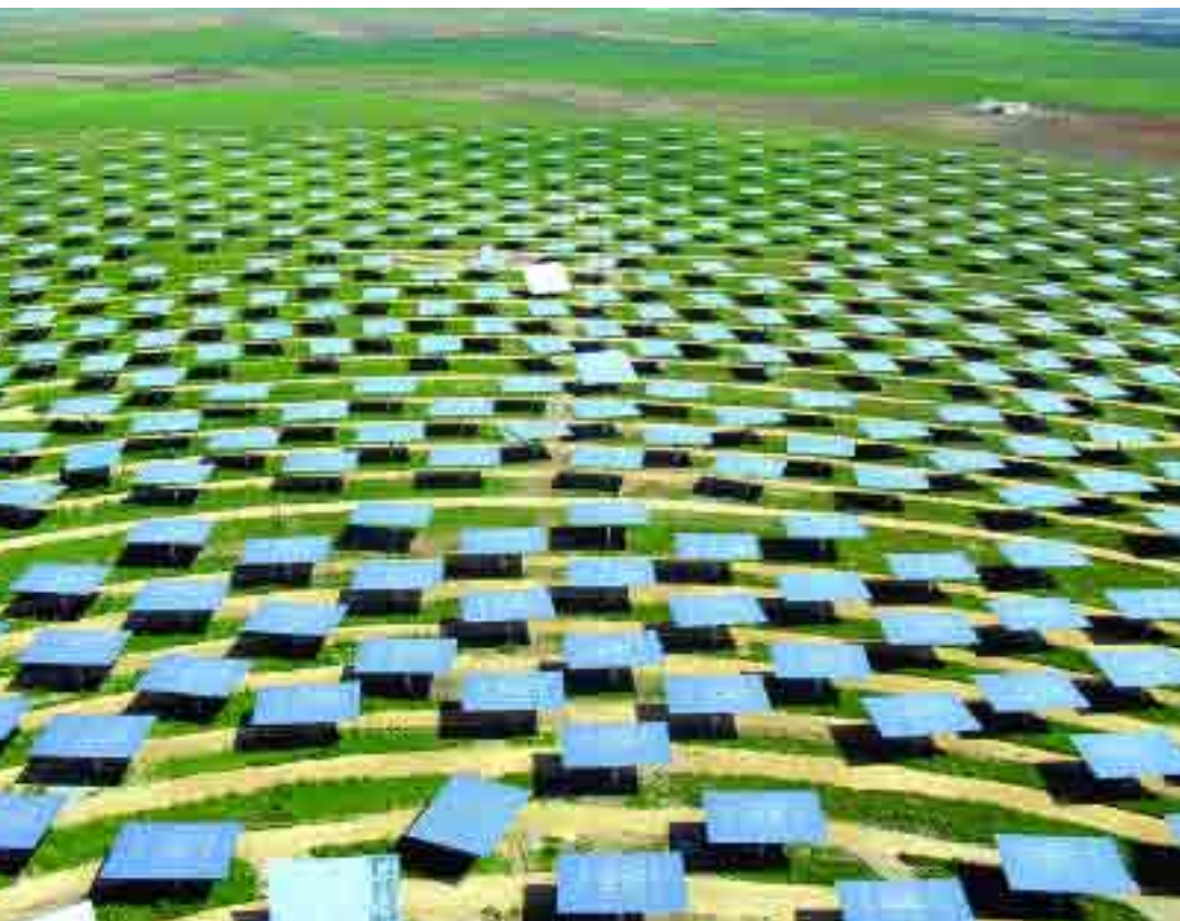
Los 624 heliostatos, de 120 m 2 cada uno, tienen forma curvada y están montados sobre estructuras de doble eje.
