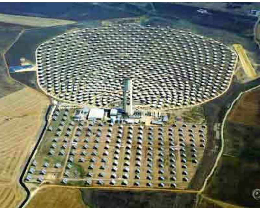
En la torre, a 100 m de altura, se ubica el receptor térmico volumétrico formado por una matriz de varias capas de mallas metálicas que luego calentarán el circuito de agua a una temperatura máxima de 255° C.
