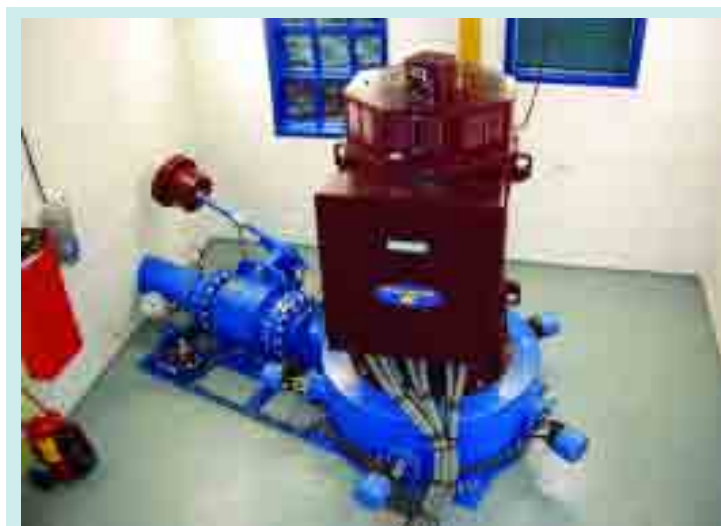
Turbina de la empresa checa Hydrolink, instalada en Noruega. Se trata del modelo Hydrohrom HHP V5.
