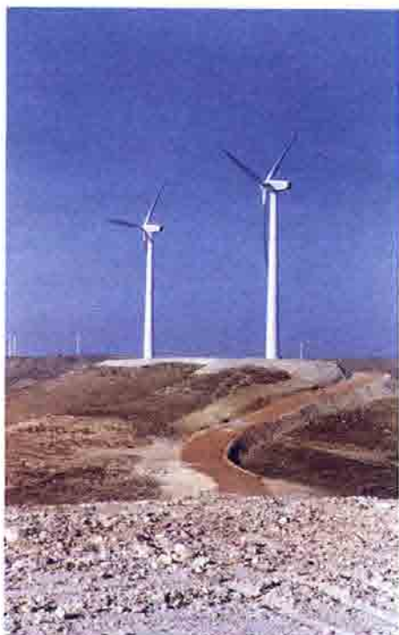
Sobre estas líneas, vista del Parque Eólico de la Muela, en Zaragoza. La imagen de portada corresponde a la instalación de Énio, en Almería. En la página de la derecha, Parque Eólico La Joya, situado en Tarifa (Cádiz).
