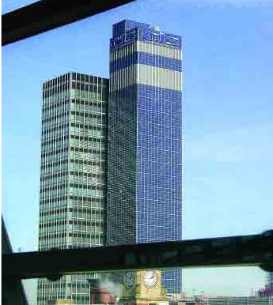
La fachada fotovoltaica de la torre CIS domina el horizonte de la ciudad de Manchester. En sus 118 metros de altura y sobre una superficie de 4.000 m 2 se ha instalado un sistema de 391 kWp de potencia.
