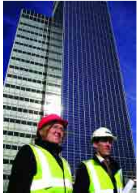
La fachada fotovoltaica de la torre CIS domina el horizonte de la ciudad de Manchester. En sus 118 metros de altura y sobre una superficie de 4.000 m 2 se ha instalado un sistema de 391 kWp de potencia.
