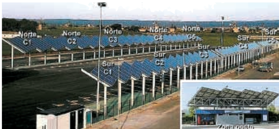
La foto de Solarta muestra la situación de los inversores en distintos puntos de la instalación.
