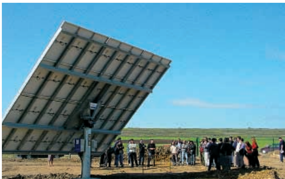
El seguimiento del sol que realiza el Buskil aumenta la producción un 35% respecto a una instalación fija.
