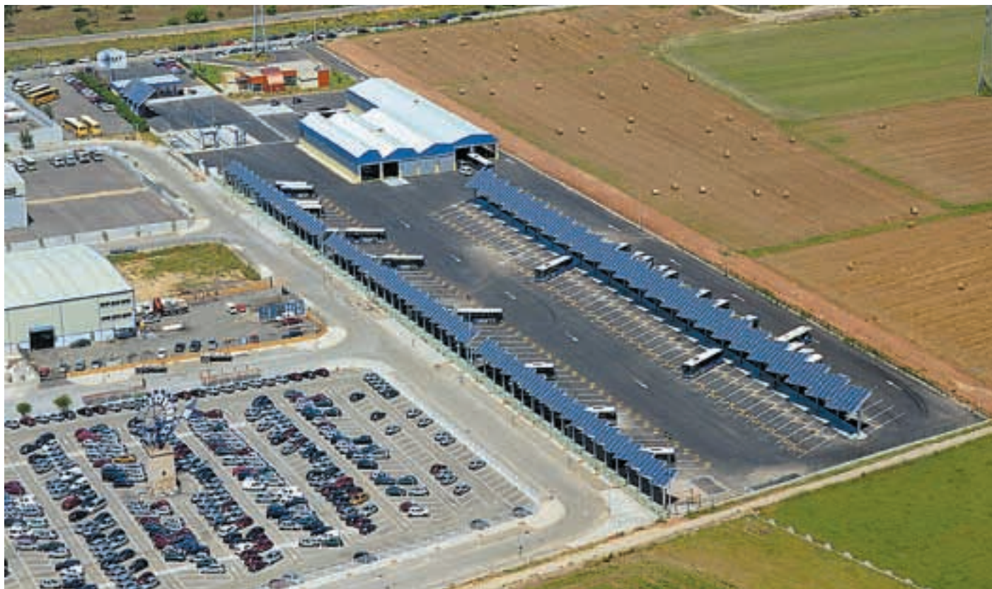
En esta imagen aérea de las instalaciones de la EMT de Palma de Mallorca puede apreciarse la perfecta integración de los paneles solares fotovoltaicos en el techo de las marquesinas.
