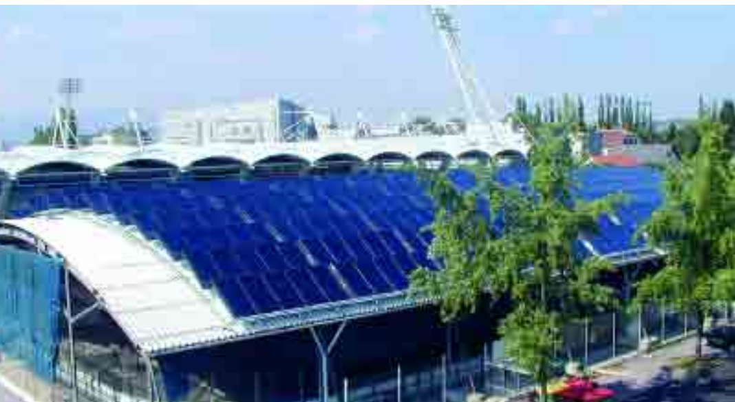
La cubierta del estadio Arnold Schwarzenegger, en Graz, (1.407 m 2 de colectores solares) es la mayor instalación de este tipo en Austria y fue puesta en marcha en 2002.
