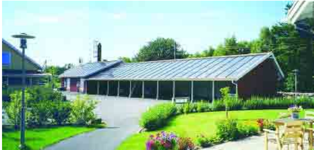
Un garaje "al sol" en la localidad de Onsala (Suecia). Tiene 220 m 2 de colectores solares, que fueron instalados en 1995.
