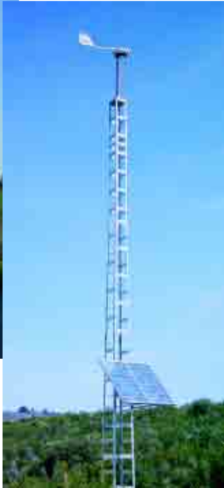
La mayoría de los mini aerogeneradores se destina a instalaciones aisladas de la red, en casas de campo, granjas, campings y otras aplicaciones aisladas, como sistemas de comunicación.
