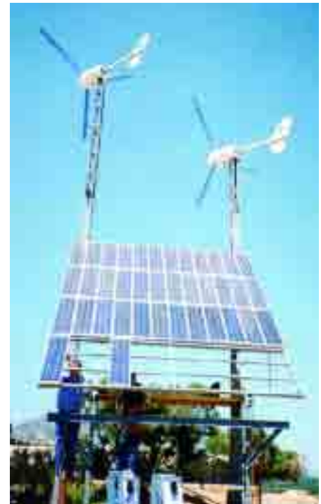
La mayoría de los mini aerogeneradores se destina a instalaciones aisladas de la red, en casas de campo, granjas, campings y otras aplicaciones aisladas, como sistemas de comunicación.
