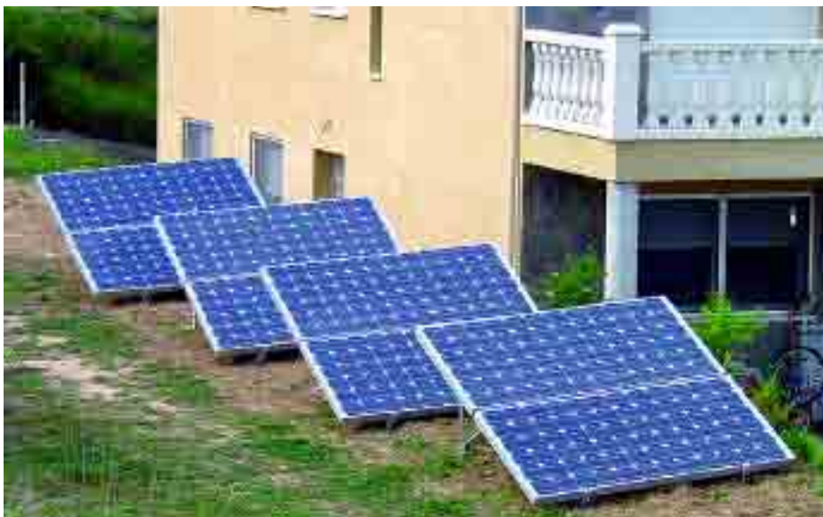
El hotel Flamingo (L'Ampolla, Tarragona) tiene instalado un sistema de energía solar que calienta dos acumuladores con una capacidad de 3.500 litros cada uno. El sistema es apoyado por dos calderas de biomasa.
