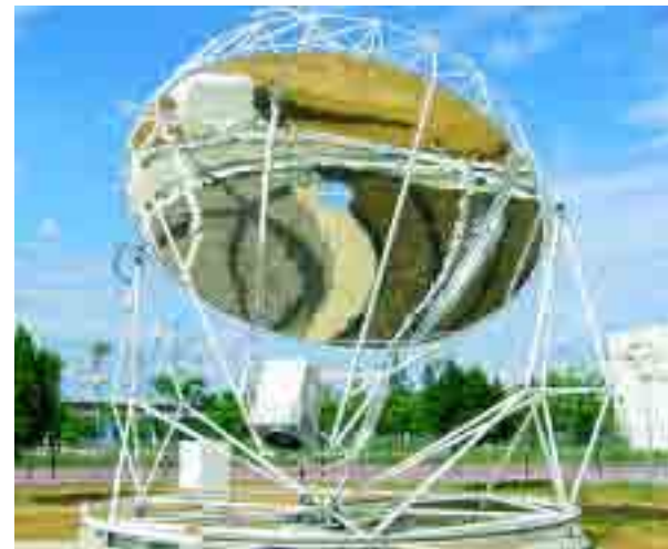
Prototipo precomercial de disco parabólico con motor Stirling de 10 kW. Instalado en la Escuela Superior de Ingenieros de Sevilla.
