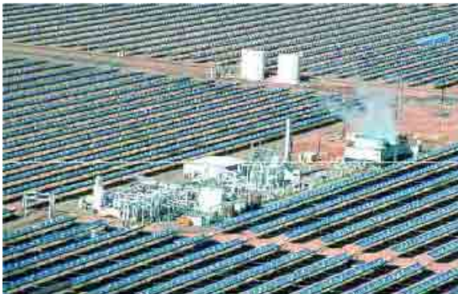
Planta híbrida sol-gas en Kramer-Jonction (California, USA).
