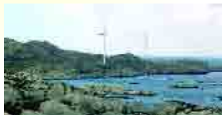
El proyecto de la isla noruega de Utsira es, hoy por hoy, uno de los más interesantes en producción de hidrógeno a partir de la energía eólica. Emplea dos aerogeneradores, un electrolizador y una pila de combustible de 55 kW.
