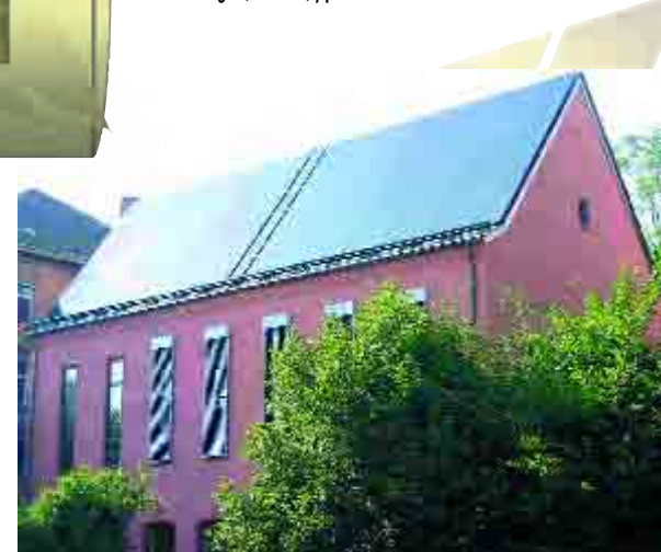
Solarturm, en la imagen superior, es una instalación fotovoltaica hecha con células CIS. Tiene una potencia de 8 kW y se encuentra en la localidad alemana de Heilbronn, cerca de Stuttgart. El tejado de abajo también está cubierto de células CIS. Está en Tübingen (Alemania) y produce 11.000 kWh al año.
