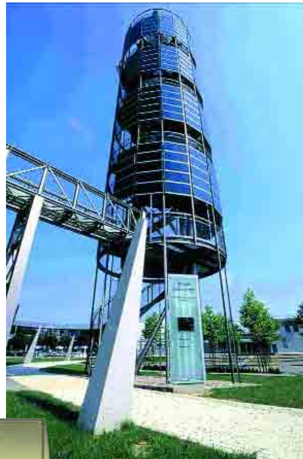
Solarturm, en la imagen superior, es una instalación fotovoltaica hecha con células CIS. Tiene una potencia de 8 kW y se encuentra en la localidad alemana de Heilbronn, cerca de Stuttgart. El tejado de abajo también está cubierto de células CIS. Está en Tübingen (Alemania) y produce 11.000 kWh al año.
