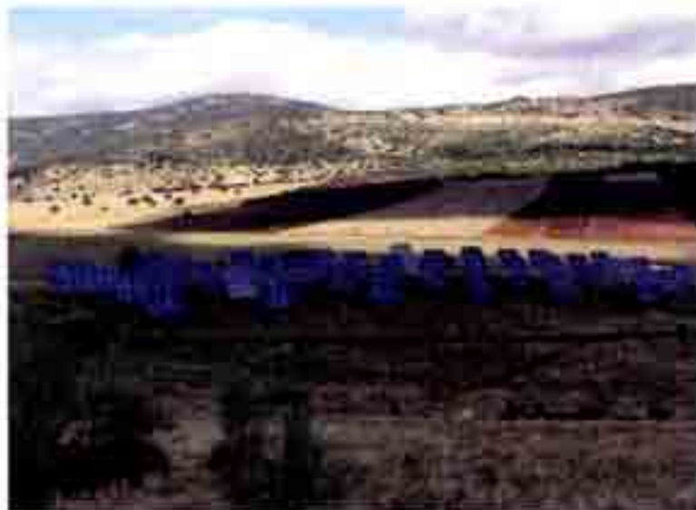
Foto de planta en marcha de la instalación de 100MW de Exploitation Navarre en colaboración con E.ON Energy Research Center.
