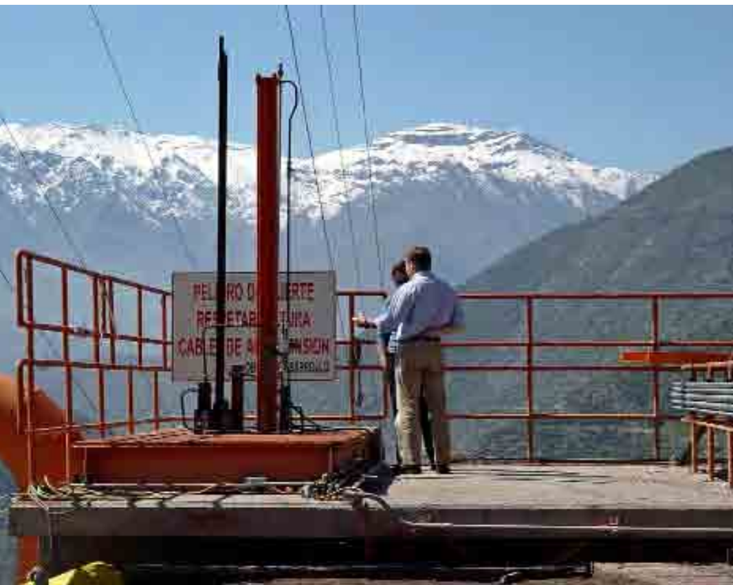
Central minihidráulica de Chacabuquito, situada al pie de los Andes. Arriba, vista desde la zona de toma de aguas. A la derecha, edificio donde se encuentra la turbina.
