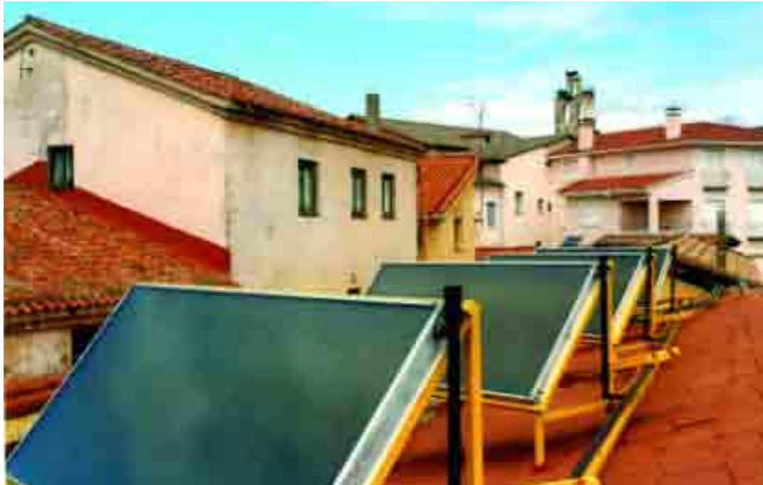
Las instalaciones solares del Taller Cabarrús cubren el 100% de las necesidades de agua caliente del centro y entre el 80% y el 90% de calefacción.
