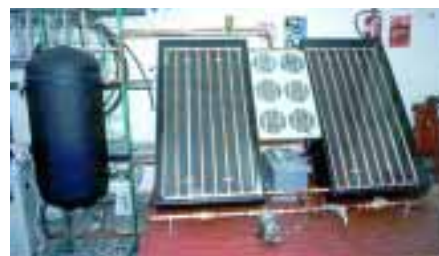
Adaptación de una vivienda a las energías renovables. Abajo, calentamiento de Agua Caliente Sanitaria por paneles termosolares con bomba de alimentación. Realizados por Ciclos Formativos y Escuelas Taller.
