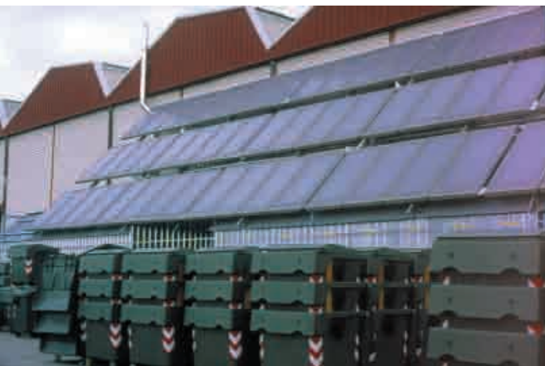
Los 150 m 2 de colectores térmicos cubren la demanda de las duchas y del túnel de lavado por donde pasan cada día contenedores y camiones de la basura. En invierno, aportan el 70% de las necesidades de calefacción.
