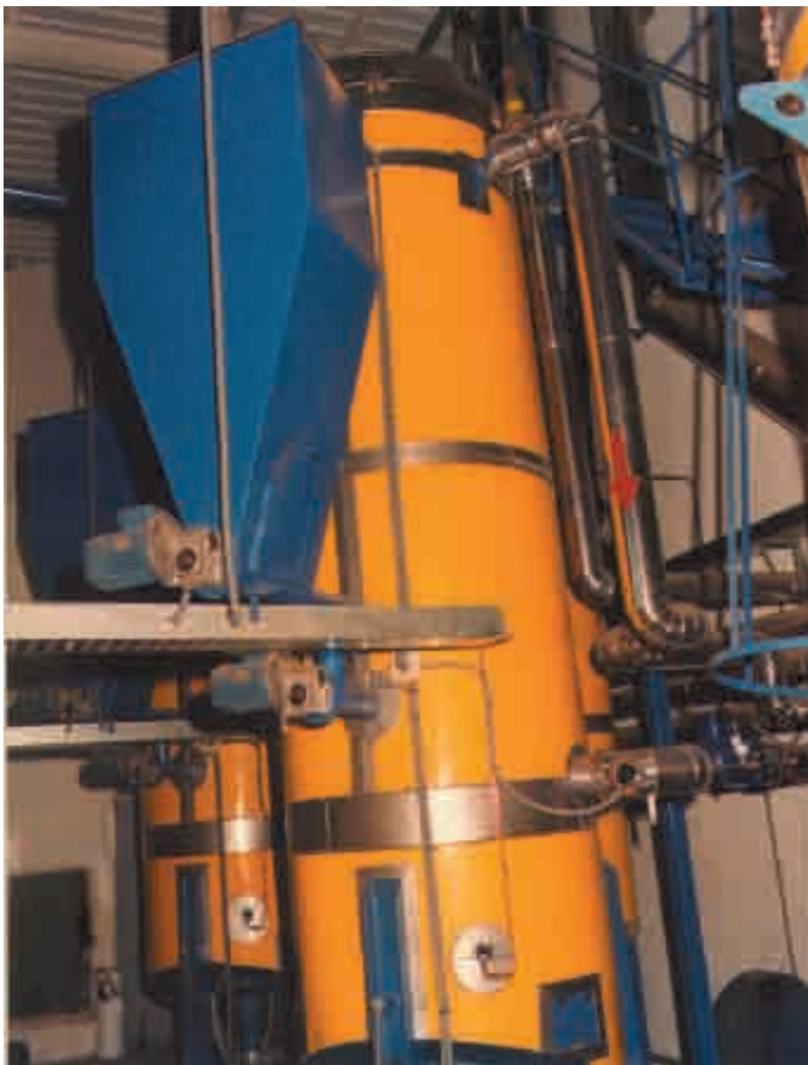
Estas son las calderas de 500 kW de potencia unitaria destinadas a calefacción. Además de cáscaras de almendra están preparadas para utilizar 15 combustibles distintos, como granilla de uva o huesos de aceituna.
