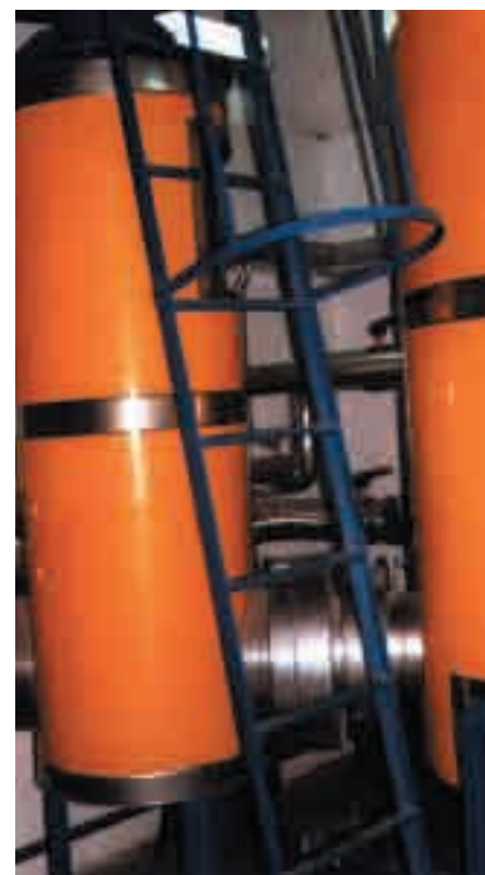
La residencia para la tercera edad de Movera (Zaragoza) abandonó el gasóleo y ahora utiliza calderas de biomasa alimentadas con cáscaras de almendra para abastecer sus necesidades de agua caliente y calefacción. A la derecha, vista general del ciclón decantador de cenizas.
