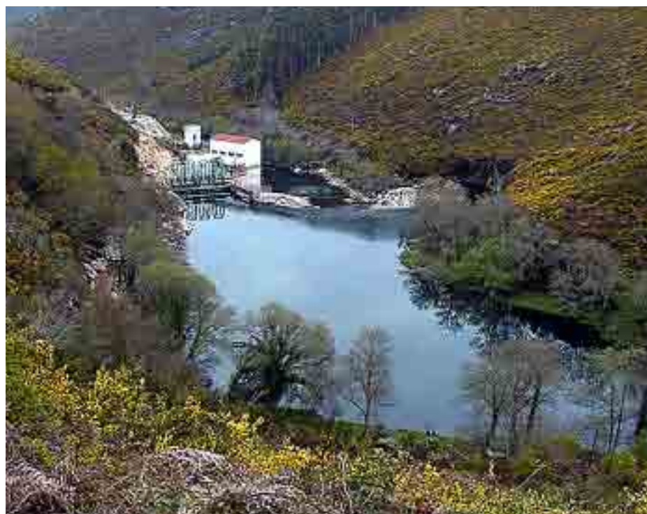
Central minihidráulica de Fecha, de la empresa Hidronorte. Se localiza sobre el río Tambre, en el término municipal de Santiago de Compostela (A Coruña). Un programa de vigilancia ambiental determinó que sus impactos eran mínimos (ver recuadro de la derecha).
