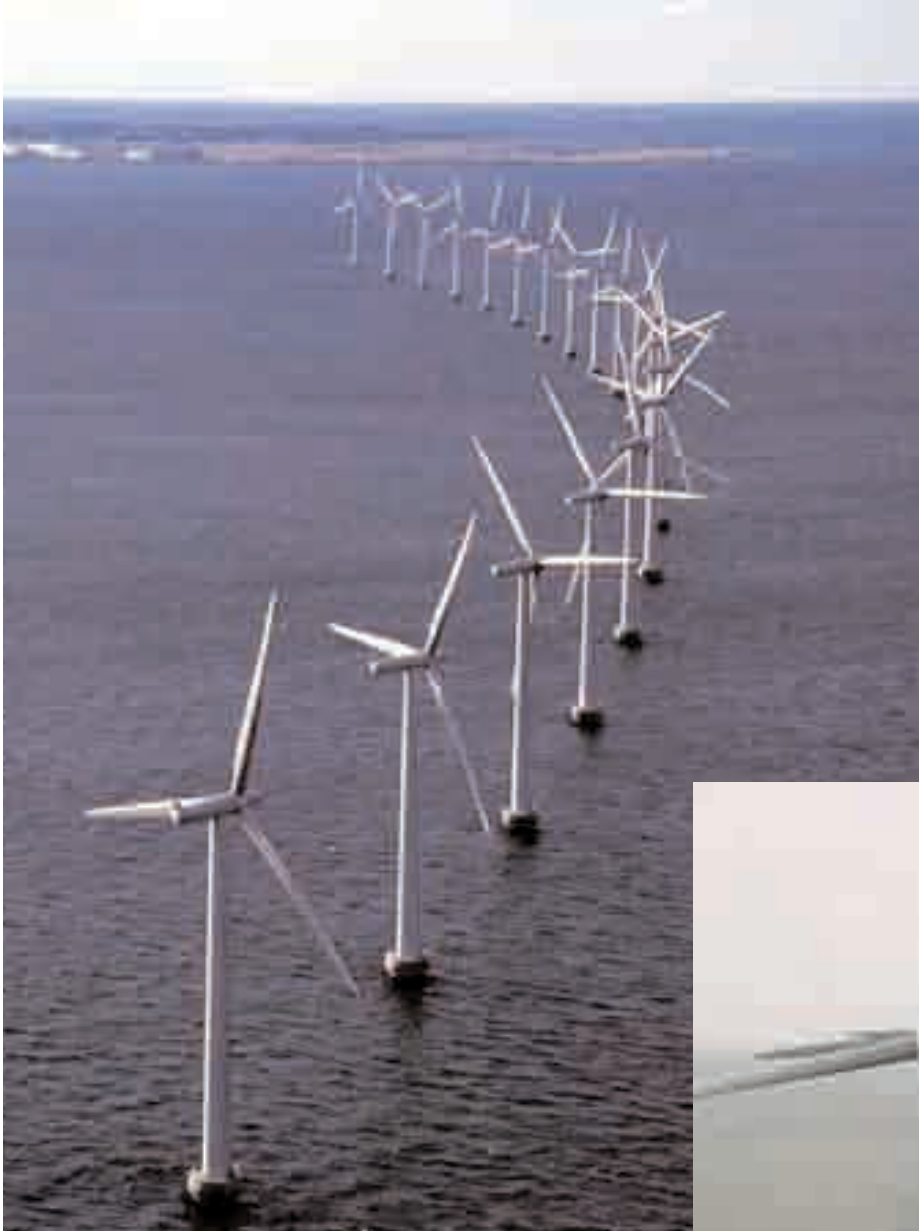
El parque eólico de Middelgunden, en la costa de Dinamarca, cerca de Copenhage, constituido por 20 aerogeneradores que suman 40 MW
