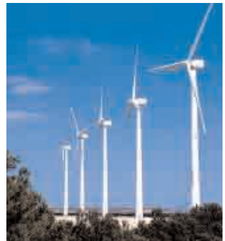
Parque eólico de Montes de Cierzo (Navarra), con una potencia de 60 MW
