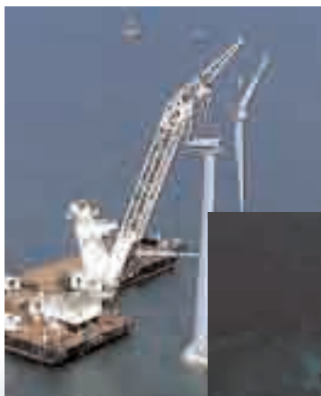
Imágenes de la construcción del parque eólico Tuno Knob, en la costa de Dinamarca, terminado en 1995 y que consta de 10 aerogeneradores de 500W.
