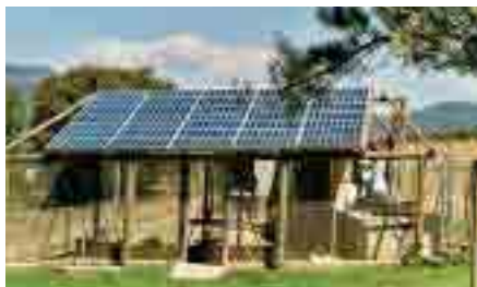
Los servicios que ofrece SEBA son integrales. Desde la elaboración del proyecto hasta la instalación de los equipos y el mantenimiento corre por su cuenta, lo que explica el éxito de esta asociación.
