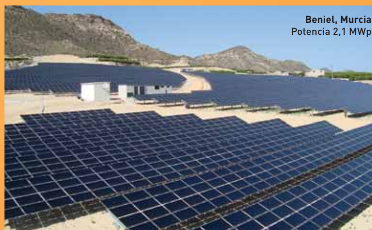
Lorca, Murcia Potencia 2,2 MWp
