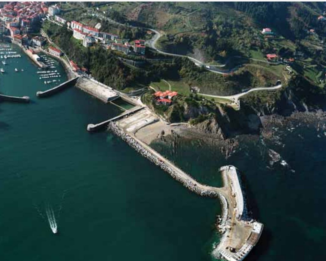
La central de Mutriku (296 kW), incrustada en el dique de abrigo del puerto de este municipio guipuzcoano, presume de ser “la primera instalación marina conectada a red de la Europa continental”. A la derecha, sistema boyante APC-Pysis.
