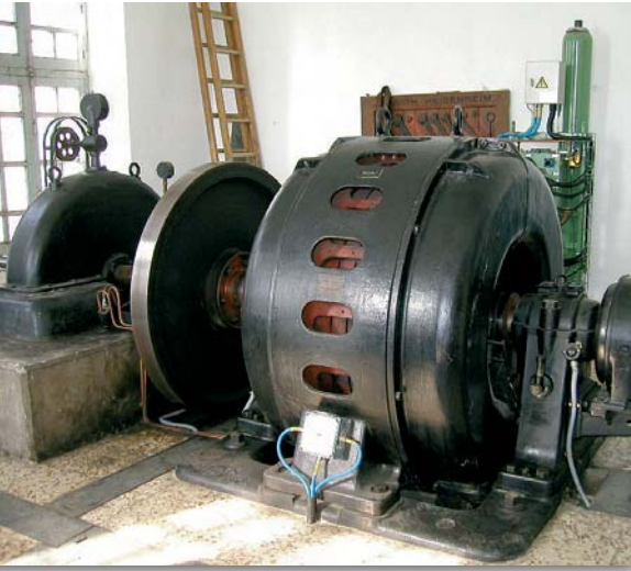
Viejo alternador de la minicentral de Los Gavilanes, en Ávila, propiedad de Iberdrola.
