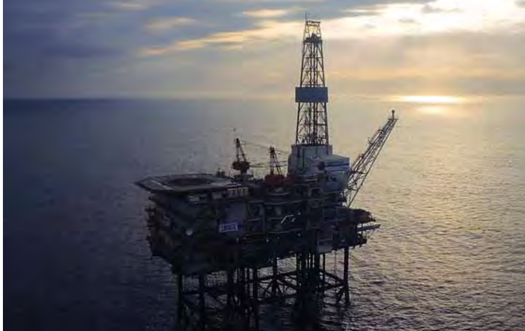
Plataforma Gaviota, destinada hoy al almacenamiento de gas natural, frente a las costas vizcaínas.
