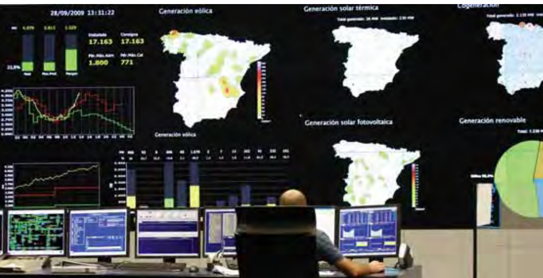
Abajo, Centro de Control de Red Eléctrica para el Régimen Especial (Cecre) desde el que se gestiona y controla la generación de los productores de energías renovables instalados en nuestro país.
