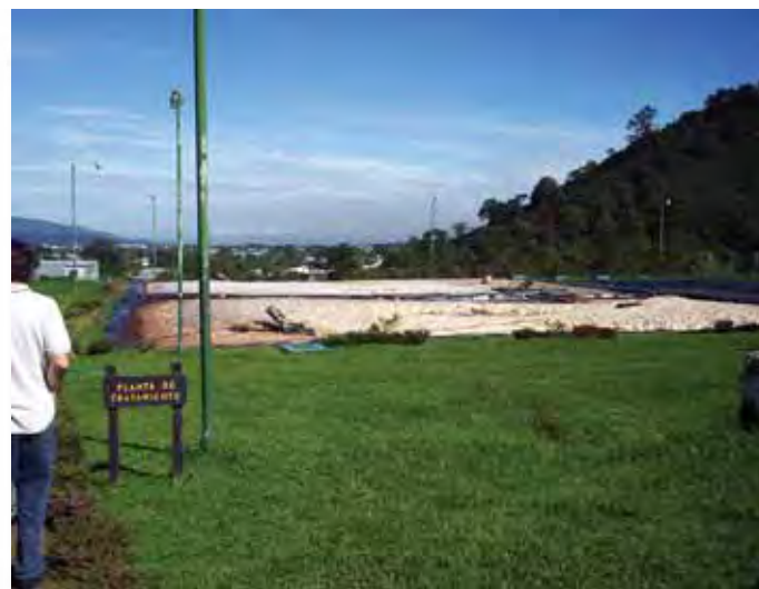
Plantas de generación en rellenos sanitarios - Río Azul. A la izquierda, biodigestor de excremento de cerdos.
