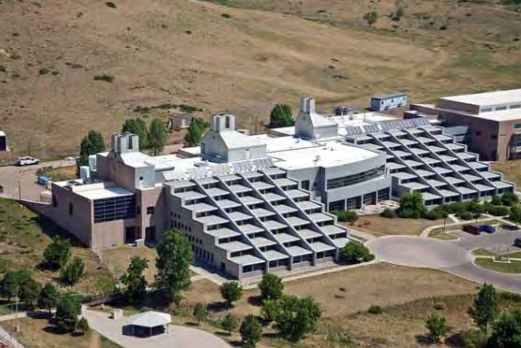
Vista aérea del Centro de Investigación para la Energía Solar (SERF)
