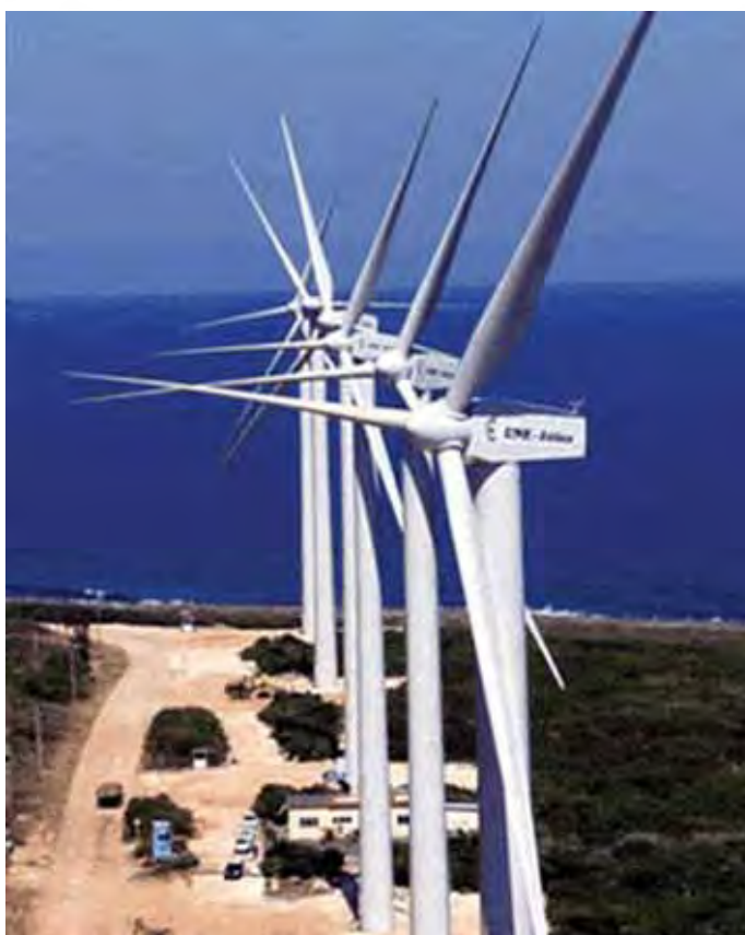
Parque Eólico Gibara 1. En página siguiente una imagen de la instalación del Parque Eólico Experimental Los Canareos.
